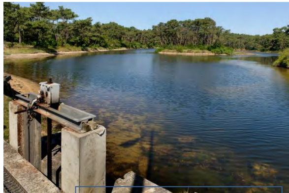
Réservoirs de Piraillan, site classé depuis 1943
