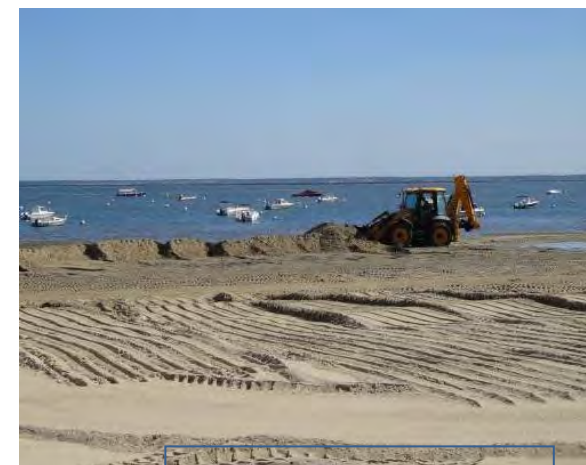
Travaux de rechargement en sable des plages
