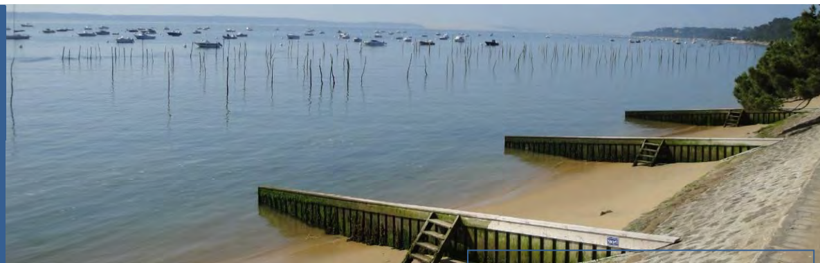
Perrés, épis et pignots le long de la presqu'île du Cap Ferret
