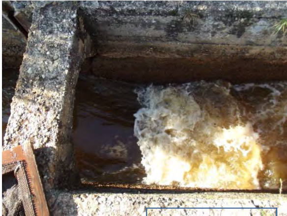
Ecluse dans un des marais
